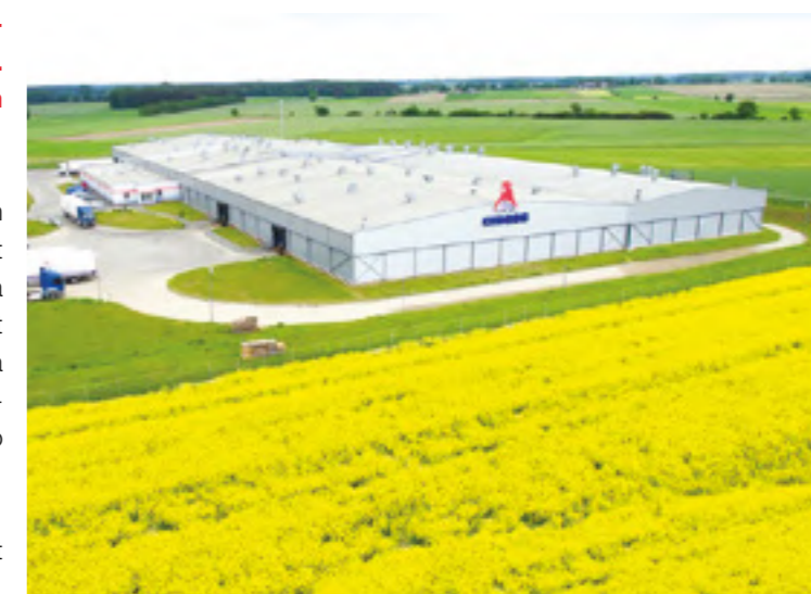
Wylęgarnia piskląt w Skarżynku, o mocy produkcyjnej 103 mln jaj wylęgowych rocznie.
